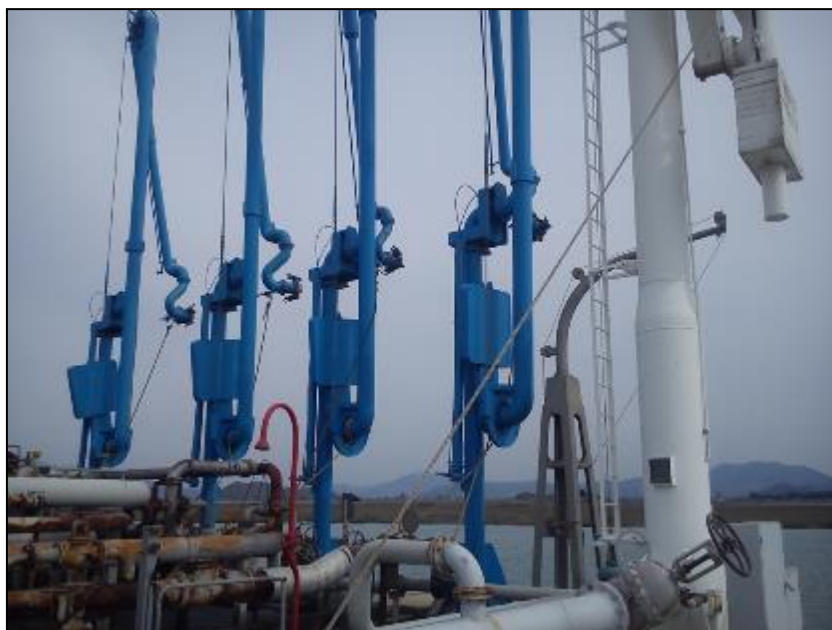
Slika 31. Zglobni utakači na brodo pretakalištu
