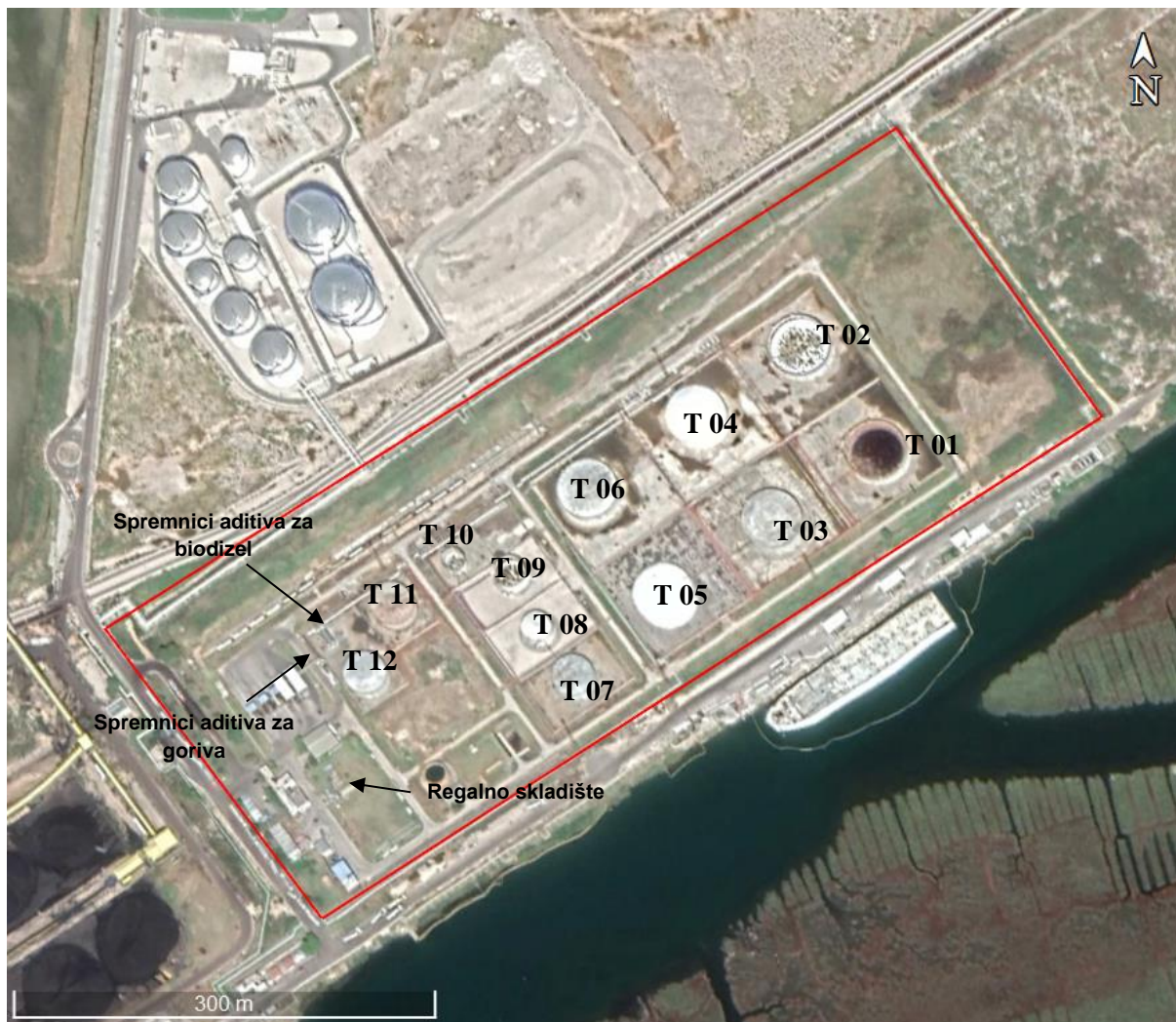
Slika 25. Skladišni prostor – NTF d.o.o. Ploče, Skladište za tekuće terete u Luci Ploče
